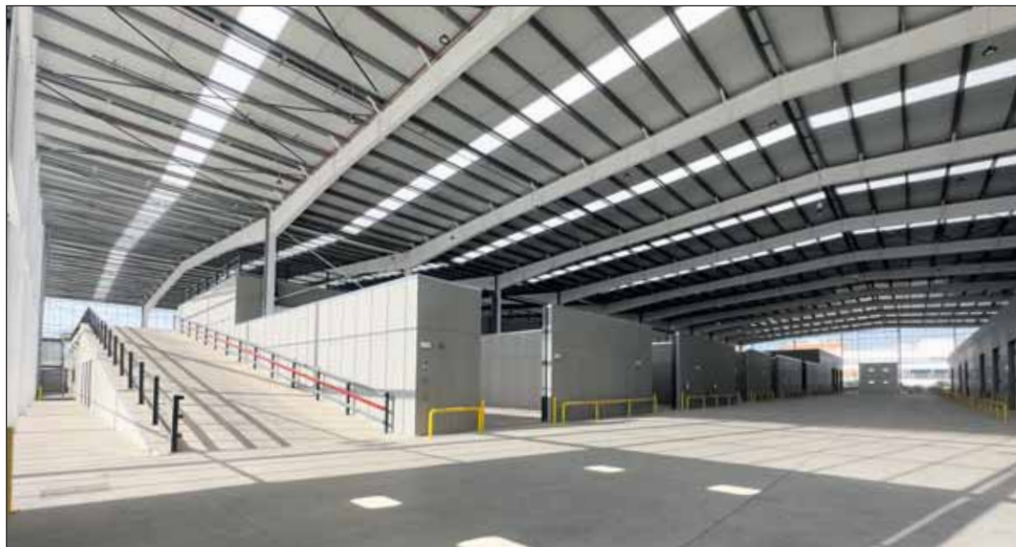
Las obras del nuevo Punto Limpio de la ciudad ya han concluido.
